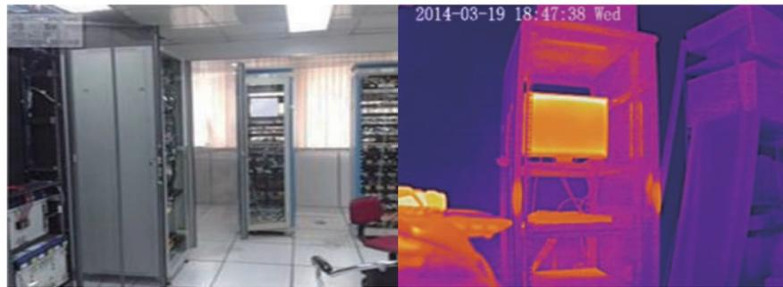
红外热成像测温监测作为一种先进的高科技监测手段，它具有利用温度来成像的无可替代优势，可应用于金融系统机房及加钞间的安全监测预警中，可实现银行安全防范和消防防范完全融合。
